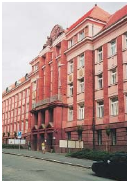
Hlavní průčelí po rekonstrukci
