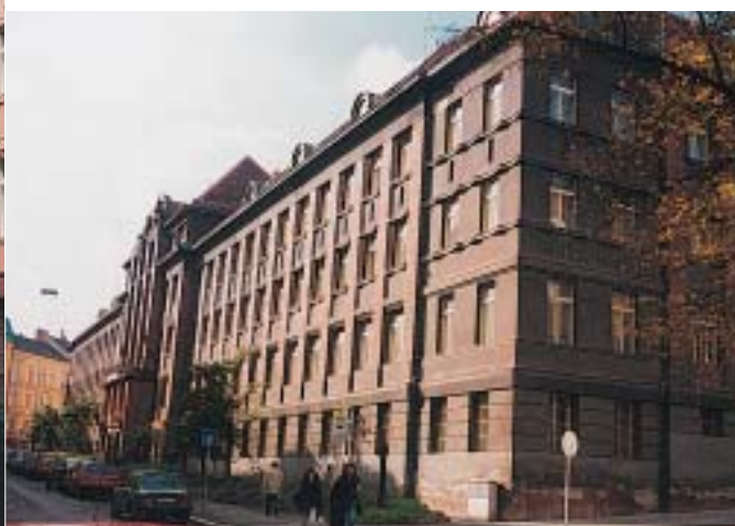
Hlavní průčelí - stav před rekonstrukcí
