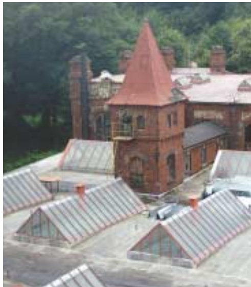
Sřtěcha po rekonstrukci. Věžička je výtahová šachta.
