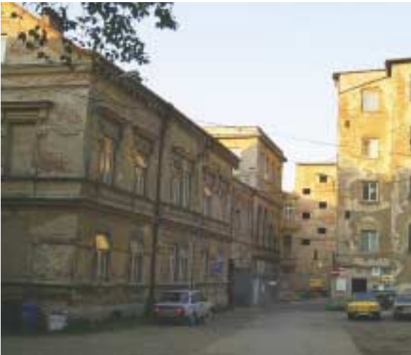
Továrna ve Vesce před rekonstrukcí
