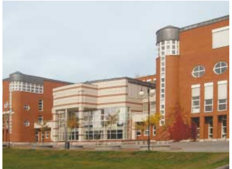
Nové centrum se staví v sousedství univerzitní budovy. Foto: redakce
