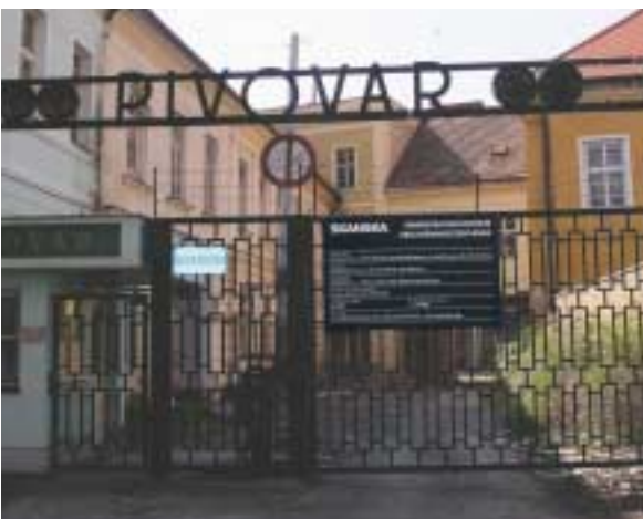
Rekonstrukce začíná (snímek z dubna 2005).
