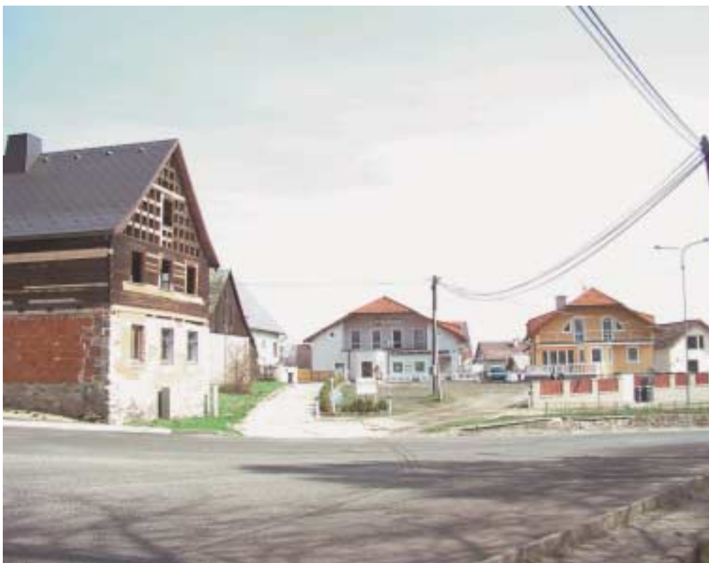
Výstavba rodinných domů ve Skalné. Foto: redakce
